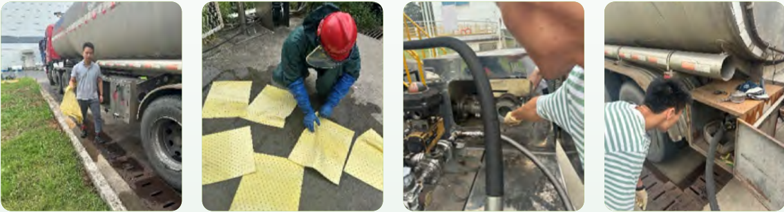
人员到场对泄露处围堵 泄露化学品收集 泄露原因调查 检查有无其他隐患
